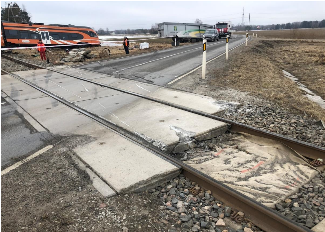
Foto 5. Ropka raudteeülesõidukoht koos rööpapead katva mustuse kihiga.
